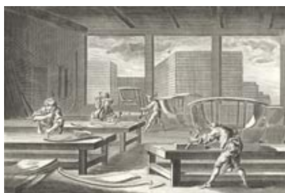
L'atelier du menuisier en voiture L'Encyclopédie ou Recueil des planches sur les sciences, les arts libéraux et les arts mécaniques , Paris, Brisson, 1771, 9 volumes, Tome IX, article "menuisier en voiture", planche I.
