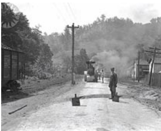
Travaux de construction de route avec l'utilisation du rouleau-compresseur / Photographie, 2 e moitié du XIX e siècle.
